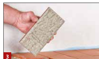
3 Verlegung der Platten im kombinierten Verfahren
