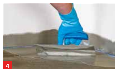
4 Aufbringen der zweiten Abdichtungslage aus MD 1 Speed
