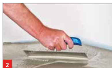
2 Aufbringen der ersten Abdichtungslage aus MD 1 Speed
