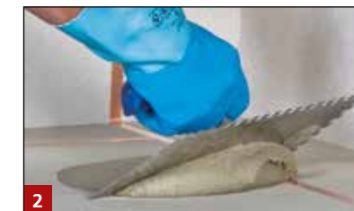
2 Aufziehen von TK 150 mit entsprechend großem Zahnpachtel
