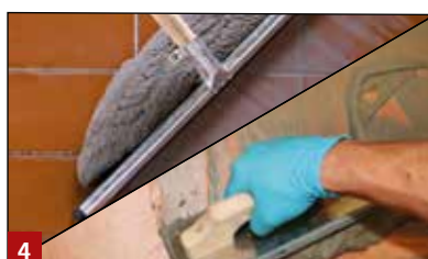
4 Einschlämmen von Multifuge Base mit Gummischieber / Verfugen mit CF 200
