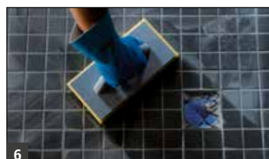
6 Verlegung des Belags mit EF 500/EK 500 Epoxidharz-Fugen- und Klebemörtel 2K oder mit Multifuge Diamond
