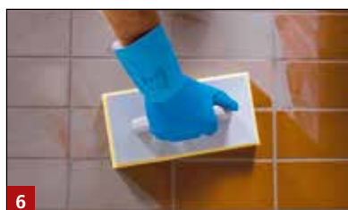
6 Schleierfreies Waschen der Multifuge Base oder CF 200
