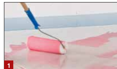
1 Grundierung von saugenden Untergründen mit D 11 oder D 1 Speed
