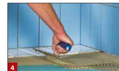
4 Aufziehen des Fliesenklebers M 21 Classic Flex-Leistungskleber oder M 29 HP Premium-Flex-Bodenkleber
