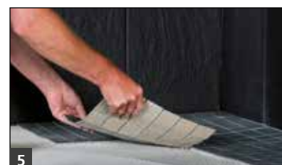
5 Verlegung des Mosaiks mit EF 500/EK 500 Epoxidharz-Fugen- und Klebemörtel 2K oder MULTISTONE
