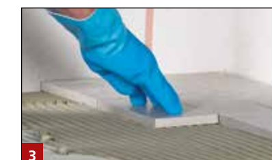
3 Einlegen der ableitfähigen Fliesen in das Kleberbett aus TK 150
