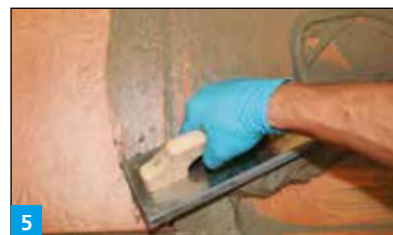
5 Verlegung der Fliesen mit CF 200* Spezialfugenmörtel
