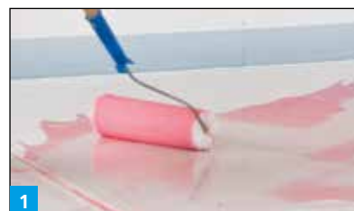
1 Grundierung des Estrichs mit D 11 Tiefengrund oder Schnelle, multifunktionale Haftgrundierung D 1 Speed
