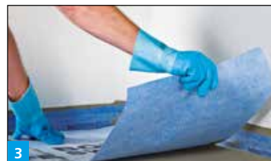
3 Einlegen der AE Abdichtungs- und Entkopplungsbahn in das frische Kleberbett aus M 21 Classic Flex-Leistungskleber oder M 21 HP Speed Premium Flex-Schnellkleber
