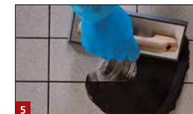
5 Einfügung des ableitfähigen Fugenmörtels SF 100
