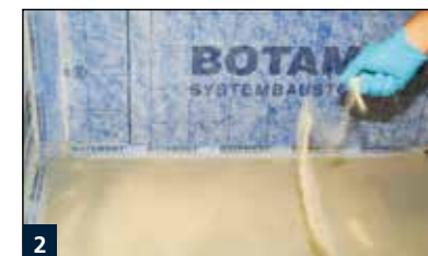
2 Abstreuen der zweiten, frischen Lage RA 170 mit getrocknetem Quarzsand für die nachfolgende Fliesenverlegung
