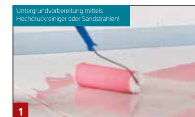
1 Grundierung der Wand- und Bodenflächen mit D 11 oder D 1 Speed
