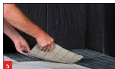
5 Verlegung des Belags mit M 21 HP. Anschließend Verfugung mit Multifuge Diamond
