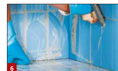
6 Verfugung mit EF 500/EK 500 Epoxidharz-Fugen- und Klebmörtel oder mit Multifuge Diamond
