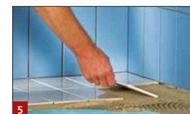
5 Verlegung der Platten an Wand- und Boden im kombinierten Verfahren mit vorgenannten Klebern
