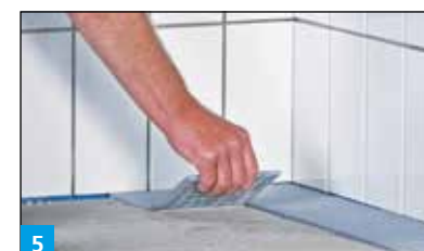
5 Einlegen der Fliesen in das frische Kleberbett
