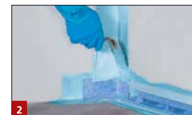
2 Applizieren der ersten Abdichtungslage aus MD 2 The Blue 1 und Einarbeitung des SB 78 Systemdichtbands samt Zubehör
