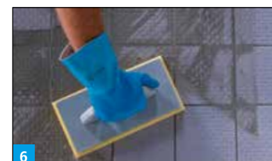
6 Verfugung der Fliesen mit Multifuge Diamond oder CF 200*
