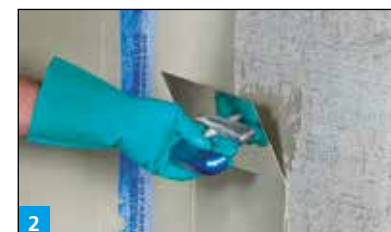
2 Aufziehen der hoch chemikalienbeständigen Abdichtung RA 170 in zwei Lagen
