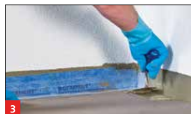
3 Einlegen des SB 78 Systemdichtbands samt Zubehör in die frische erste Abdichtungslage
