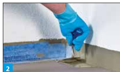
2 Verkleben von SB 78 Systemdichtband + Innenecke mit M 21 Classic Flex-Leistungskleber oder M 21 HP Speed Premium Flex-Schnellkleber
