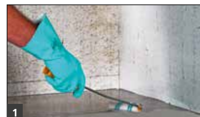
1 Grundierung des Untergrunds mit E 120 Epoxidharzgrundierung
