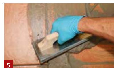
5 Einfügen von CF 200 mit Fugbrett
