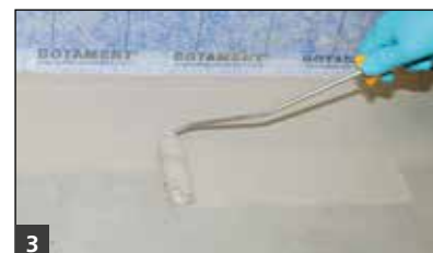
3 Applizieren der zweiten Abdichtungslage aus BOTAMENT® RA 170 Reaktionsharzabdichtung 2K
