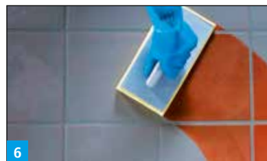
6 Leichtes, schleierfreies Waschen des Fliesenbelags
