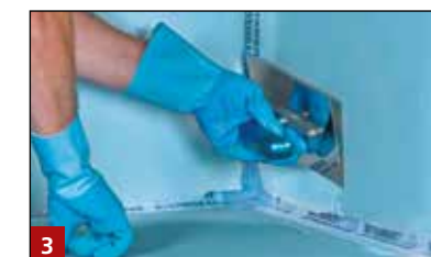
3 Applizieren der zweiten Abdichtungslage aus MD 2 The Blue 1
