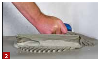
2 Aufziehen des Premium-Flex- Bodenklebers M 29 HP oder M 30 HP S2 Premium-Flex-Bodenkleber
