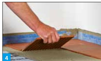
4 Verlegung der Fliesen mit M 29 HP Premium Flex Bodenkleber oder Premium Flex-Bodenkleber M 30 HP S2
