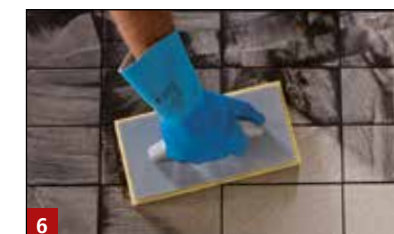
6 Waschen des ableitfähigen Fugenmörtels SF 100. Wichtig hierbei ist, dass eine oberflächenbündige Fuge erstellt wird.
