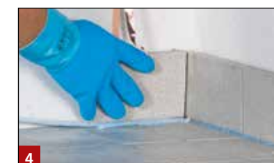
4 Ansetzen des Sockels mit TK 150
